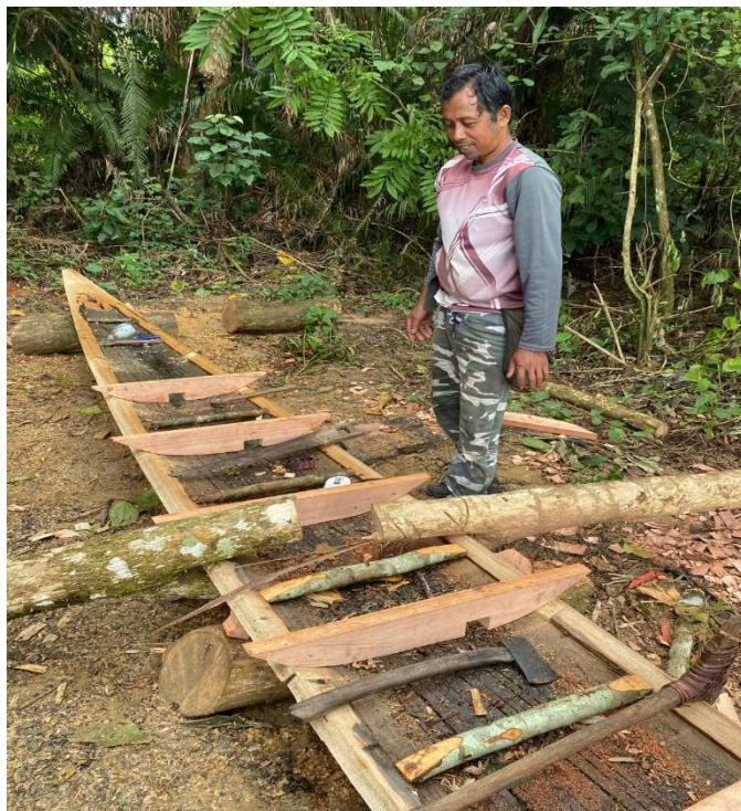
Gambar 2. Seorang Tukang Timbal Pahang Menghasilkan Sebuah Perahu Kayu yang Dikenali sebagai Perahu Jalur dengan Menggunakan Kayu Meranti
