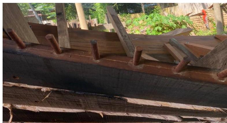
Gambar 5. Penggunaan Pasak yang Digunakan untuk Memasang Dinding Perahu
