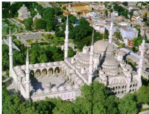
Gambarfoto 15 : Masjid Sultan Sulaiman – Istanbul. Masjid tersebut yang dibangunkan semasa zaman kerajaan Usmaniah menunjukkan dengan jelas gagasan hypostyle atau gayarupa asli Arab. Tambahan yang telah diberikan ialah pada binaan kubah tengah dan menara.
