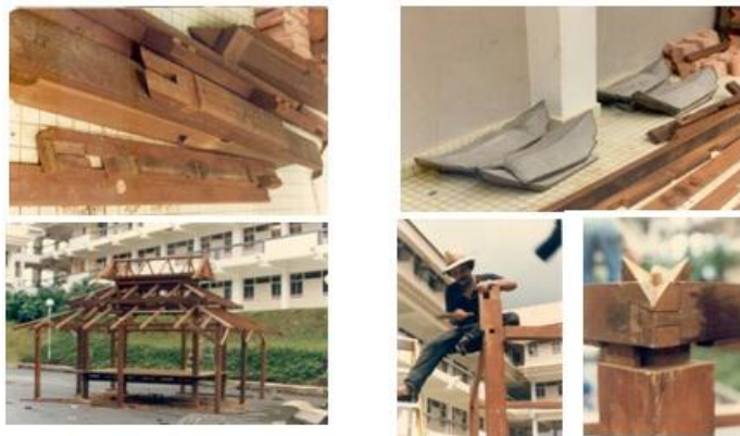
Himpunan Gambarfoto 24 : Bahan kayu dan contoh teknik binaan berangka. Orang Melayu sangat mahir dalam pertukangan kayu dan sistem binaan berangka kayu.
