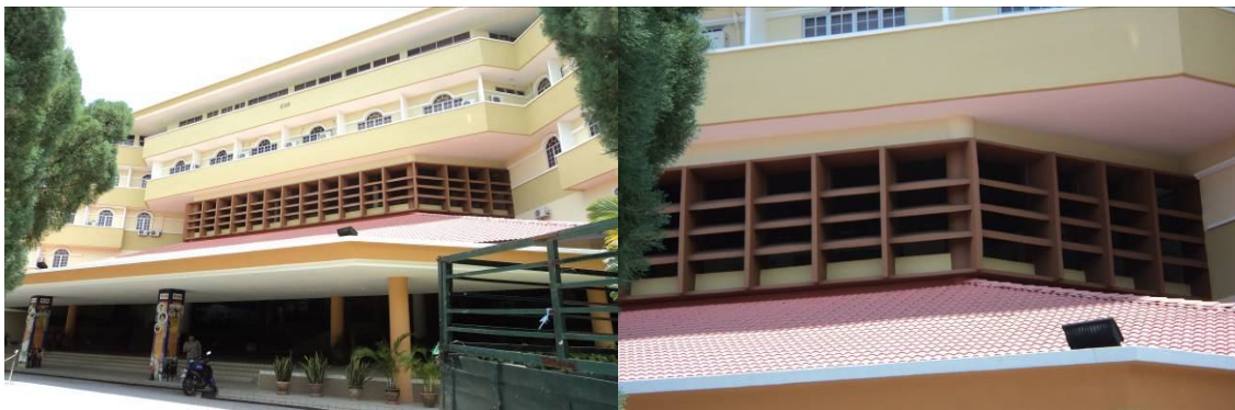
Gambar 2: Contoh Alat Peneduhan “Hung Louvers” Yang Digunakan Pada Arah Barat Bangunan Canselori USM
