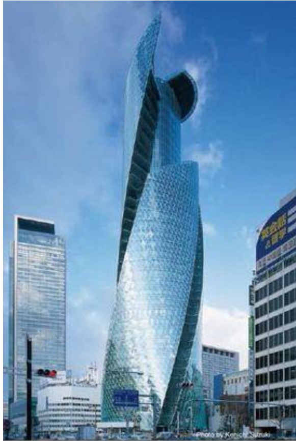
Gambarajah 10 Fasad bangunan Made Gakuen Spiral Tower yang menggunakan fasad kaca dua lapisan untuk mengurangkan penggunaan tenaga untuk sistem HVAC dengan cara menyediakan penebat udara semulajadi dan pengudaraan semulajadi melalui laluan udara dalaman dan luaran diantara dua lapisan.
