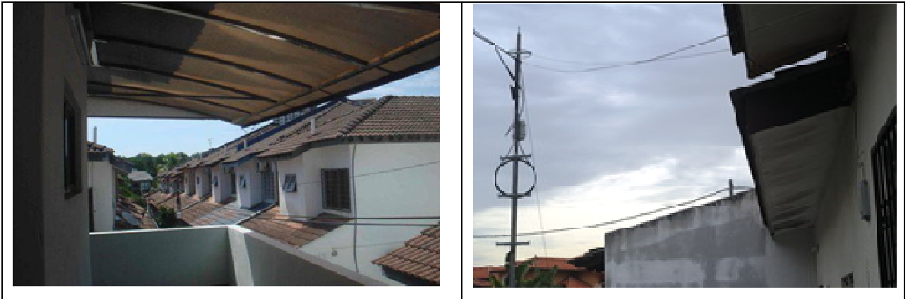
Gambar diambil di perumahan Sg Long. Dibina 1994.
