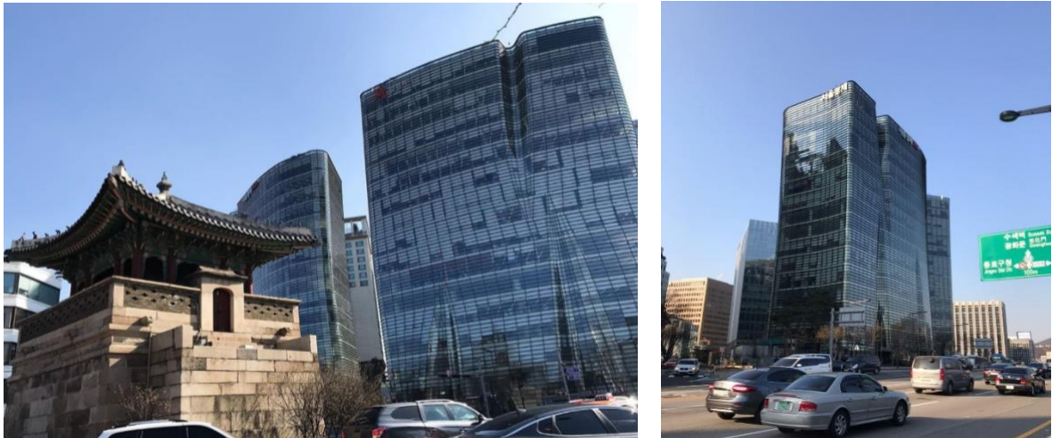
Gambarajah 8.0: Fasad kaca Menara Twin Tree Sumber: Penulis
