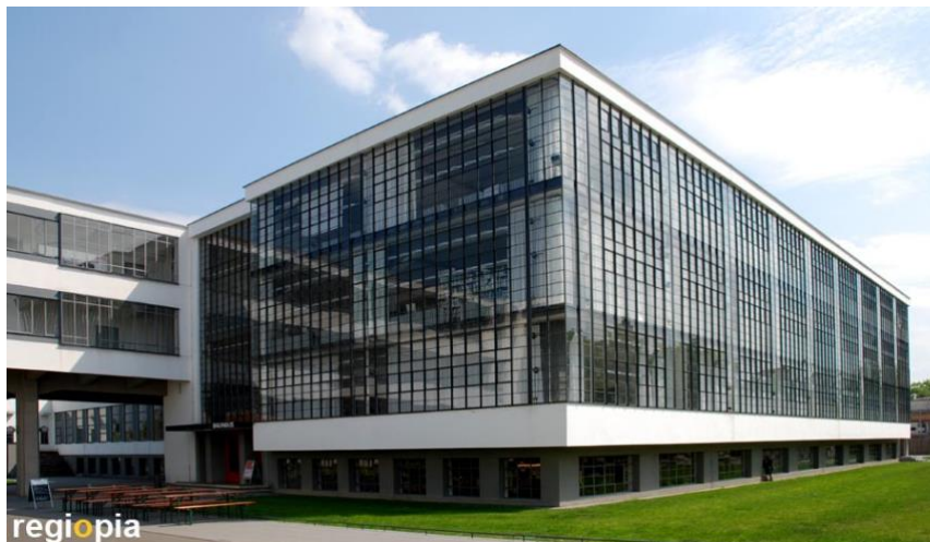
Gambarajah 1: Contoh pengadaptasian " curtain wall " dalam rekabentuk bangunan – Bauhaus, Dessau
