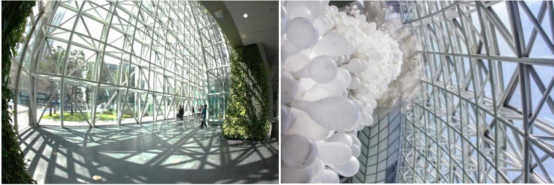
Gambarajah 11 & 12: Fasad Kaca yang menggunakan sistem 'curtain wall' menegak dalam bangunan Seoul City Hall.
