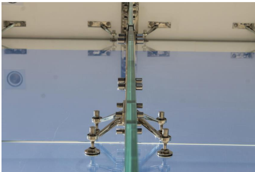
Gambarajah 3: Contoh “ Spider System ” dalam rekabentuk bangunan. KIA Store Point Support Glass Façade - Ensanada, Mexico. (Sumber: https://www.cnmorn.com/kia-store-point-support-glass-facade.html )
