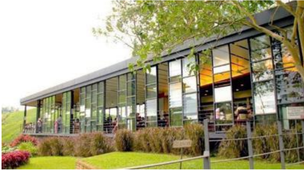
Gambarajah 9: BOH Visitor Centre, rekaan Mastor Surat yang direka bentuk menggunakan bentuk asas geometri disamping penerapan elemen hijau alam sekitar pada binaan dinding. (Sumber: Penulis)
