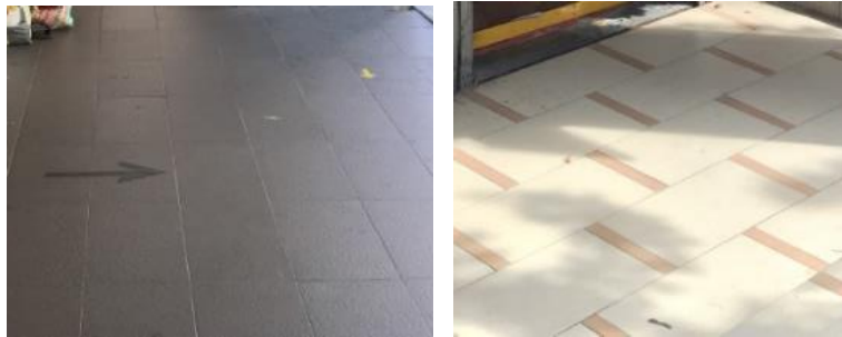
Gambarajah 8: Corak kaki lima yang dominan didapati di rumah kedai Jalan TAR Sumber: Penulis, 2021
