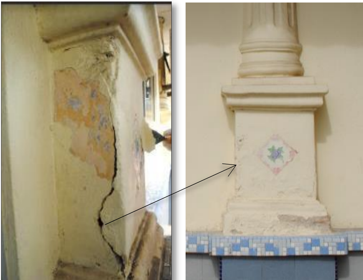
Rajah 9: Kerosakan lepaan pada tiang
